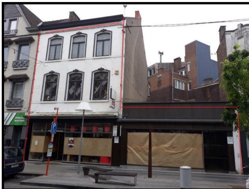
Situation existante – N° 45-47
