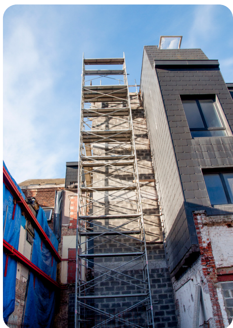
Etat d'avancement des travaux en 2022
