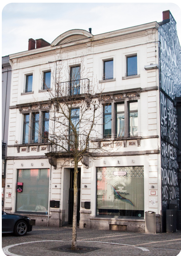
Le bâtiment sis Place Mansart logeant deux maternités commerciales.
